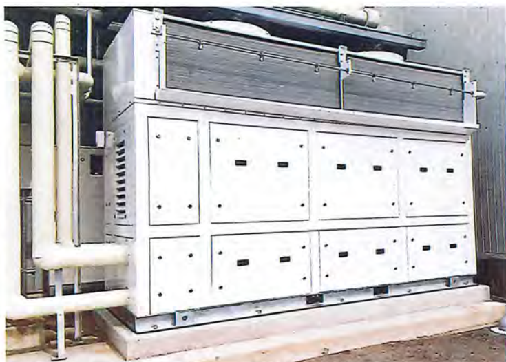
滋賀県の冷凍冷蔵倉庫会社に納入した冷凍機「SG-F3 DT」、冷凍・冷蔵の同時運転ができる特別仕様のタイプ(能力は101.7kW)
