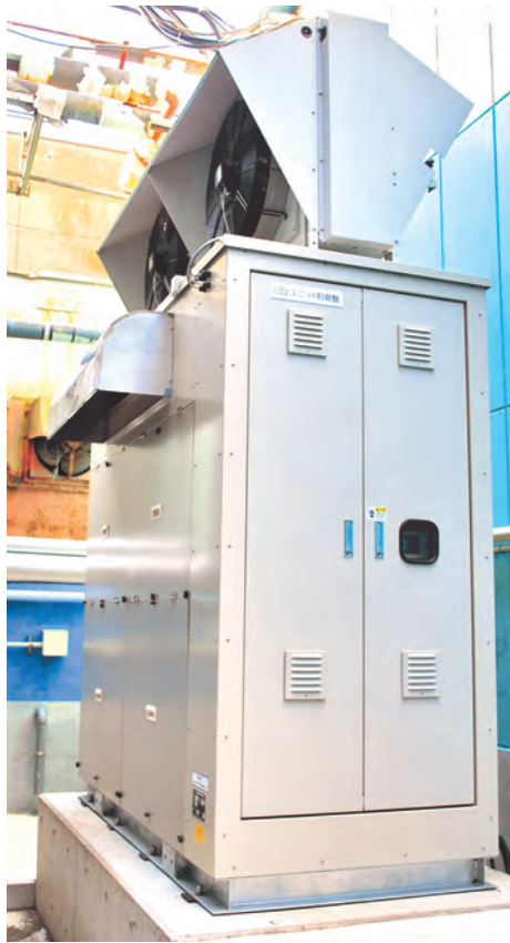
島倉水産冷蔵庫の4階の屋内スペースに設置された「スーパーグリーン」を視察する冷蔵業者ら。3階と2階の冷蔵庫(庫腹6千ト)を冷やす
