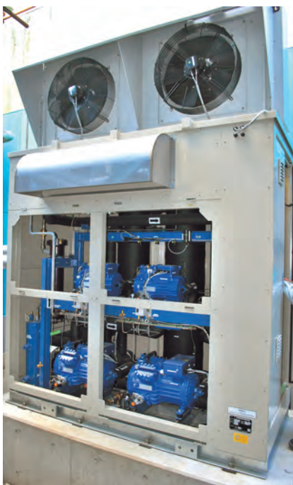
④東北水産冷蔵庫の屋外に設置されたCO 2 冷凍機「SG-F2型」 ⑤内部の圧縮機(青色)。上段と下段の2機で1セット
