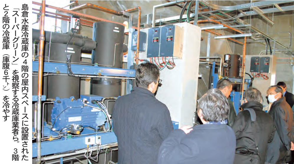
④東北水産冷蔵庫の屋外に設置されたCO 2 冷凍機「SG-F2型」 ⑤内部の圧縮機(青色)。上段と下段の2機で1セット
