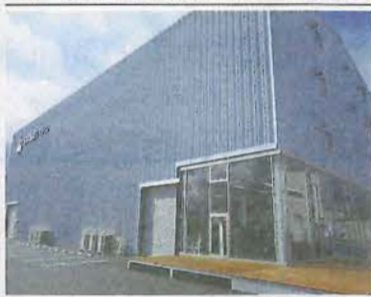
CO 2 冷凍機の増産体制を確立した日本熱源システム。滋賀工場第三工場棟。1階には環境配慮型4製品を中心としたショールーム
